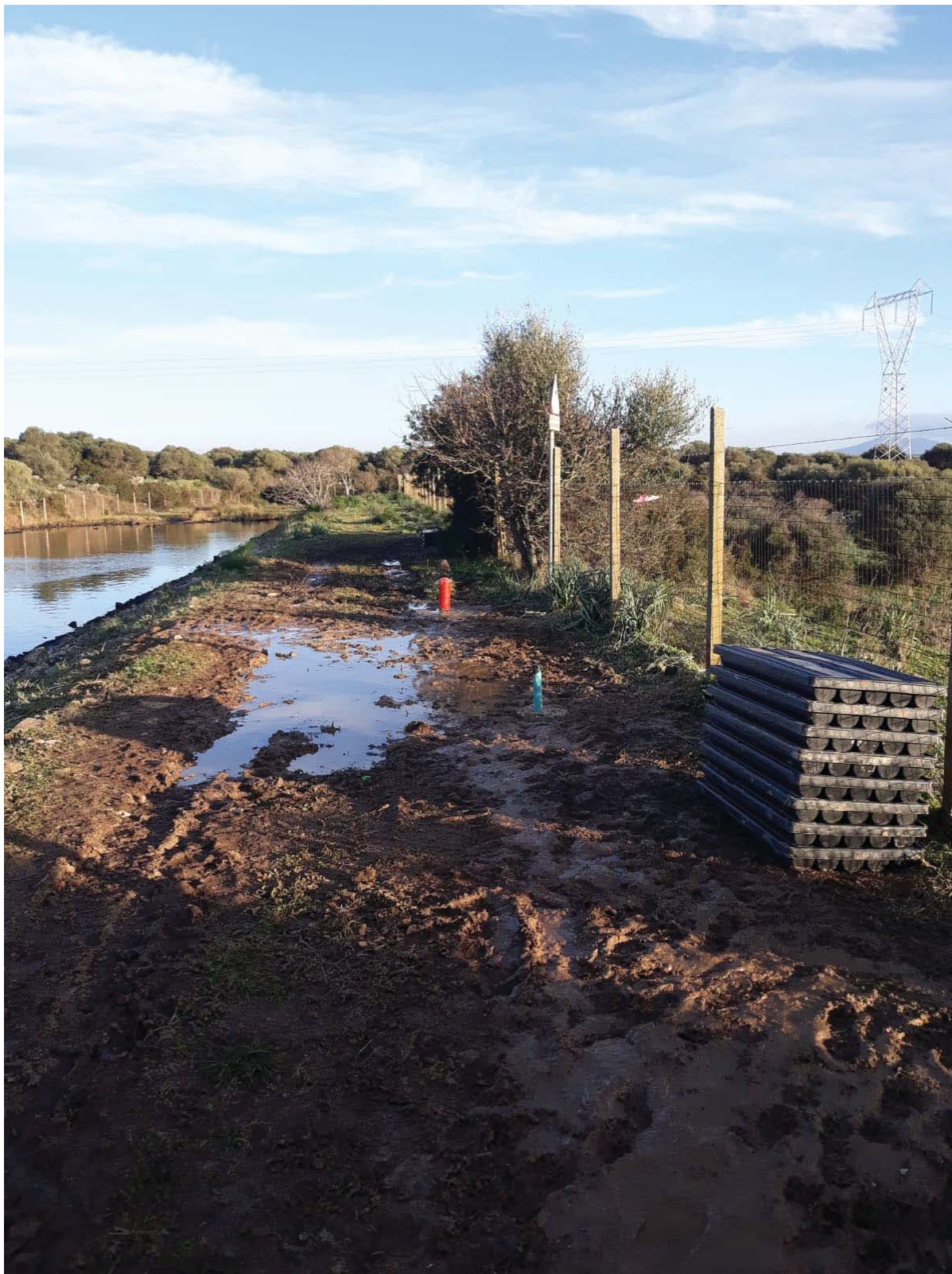
Fig.34: Termine delle operazioni di cantiere sul coronamento (in primo piano piezometro S3)
