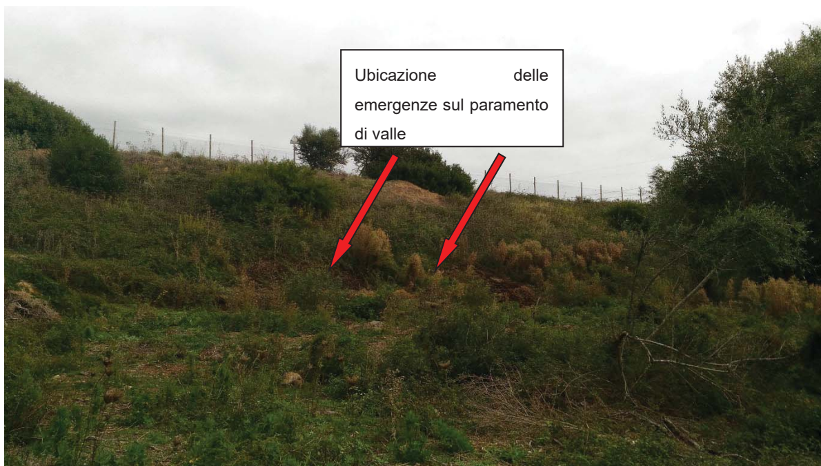
Fig.2: Ripresa fotografica del paramento di valle con ubicazione delle emergenze
