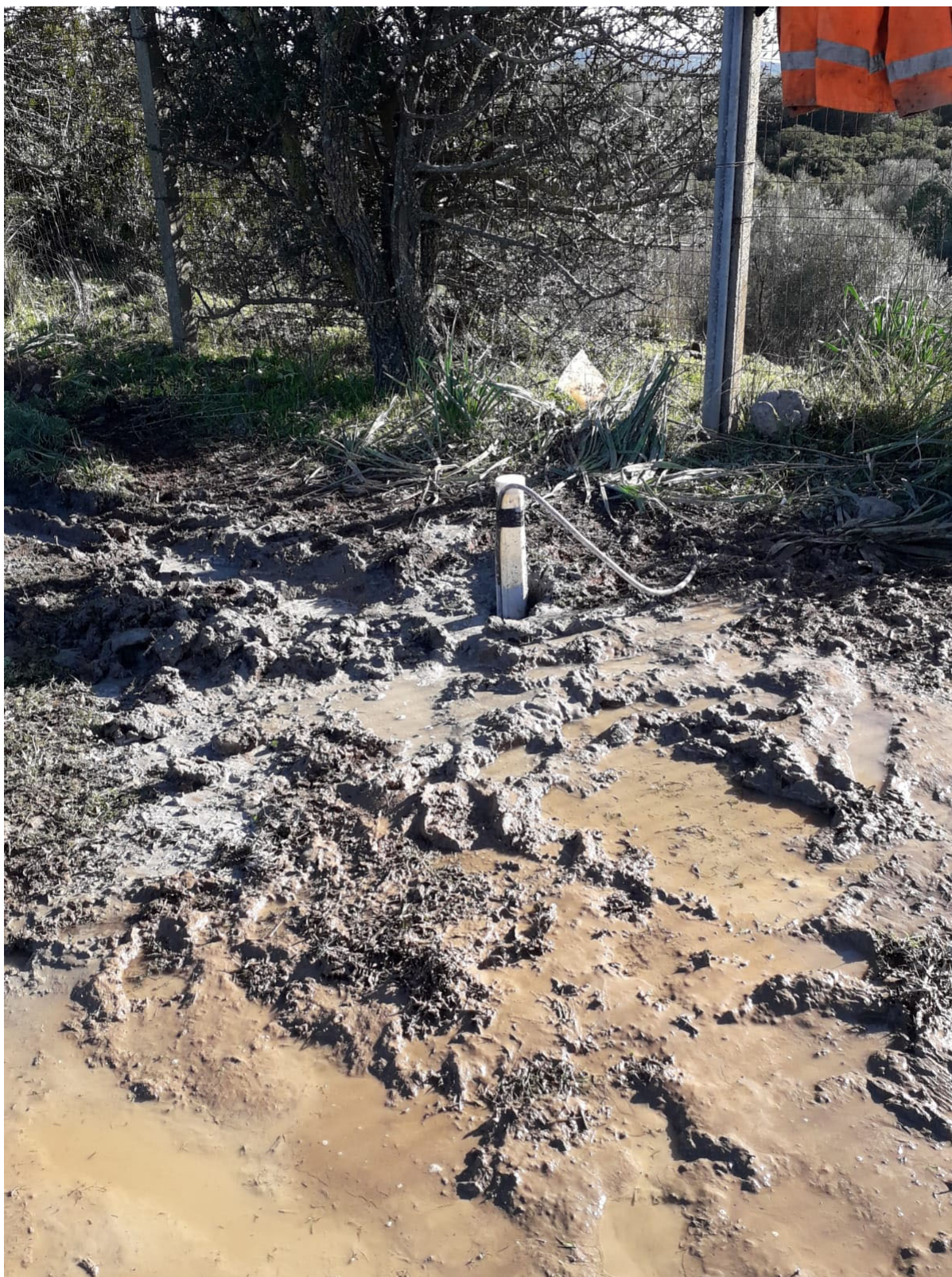
Fig.30: Sondaggio geognostico S2 - Diga Mura Cabonis – Allestimento Inclino metro in ABS
