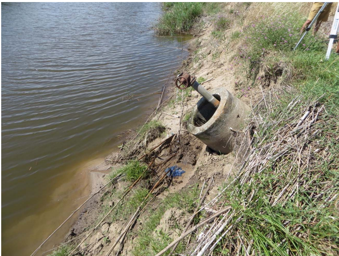
Foto n. 2 – Particolare della bocchetta di presa del Consorzio di Bonifica dell'Oristanese sradicata.
