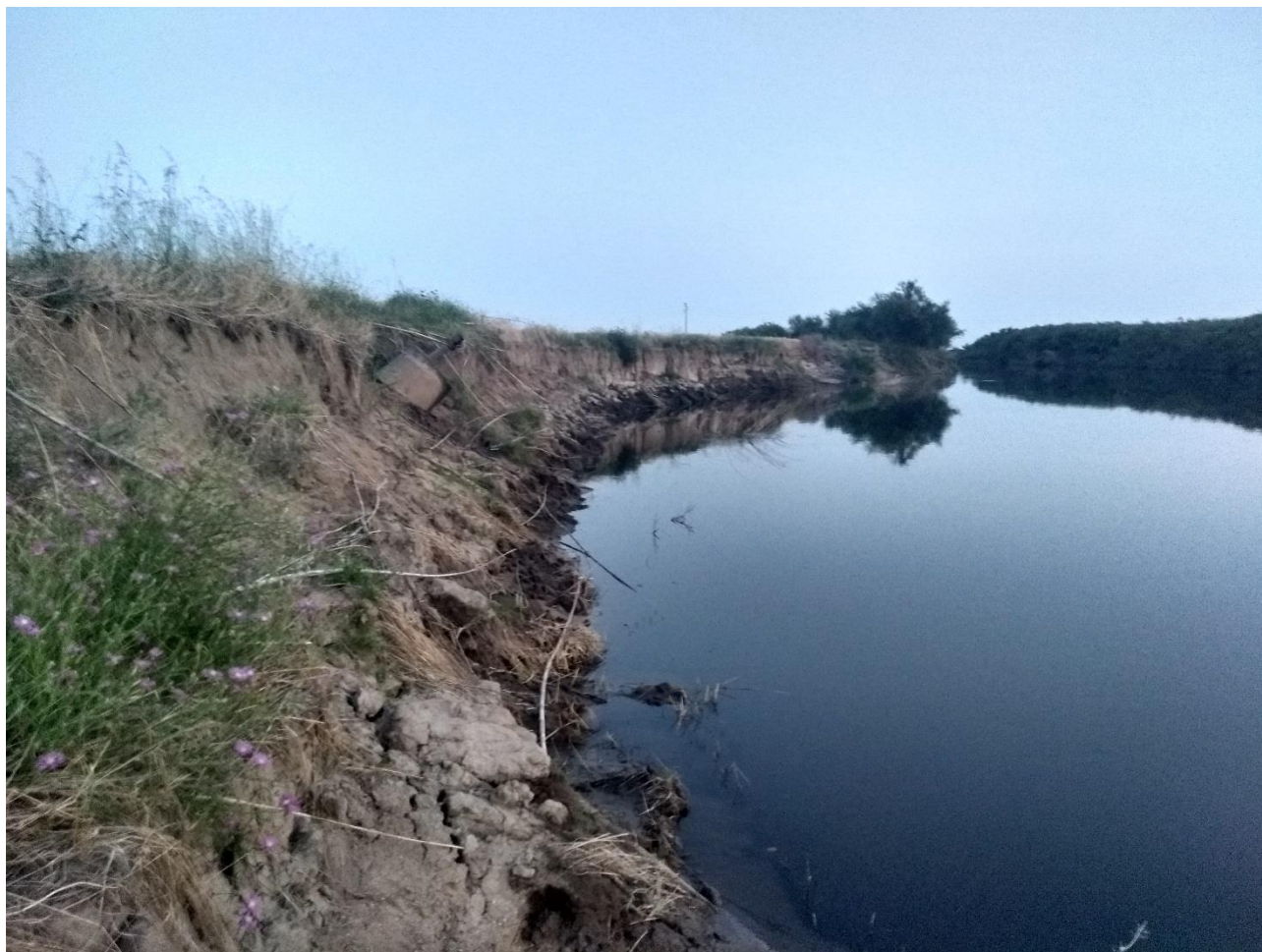
Fig. n. 4 – Sponda in erosione con in primo piano la bocchetta di presa irrigua franata.
