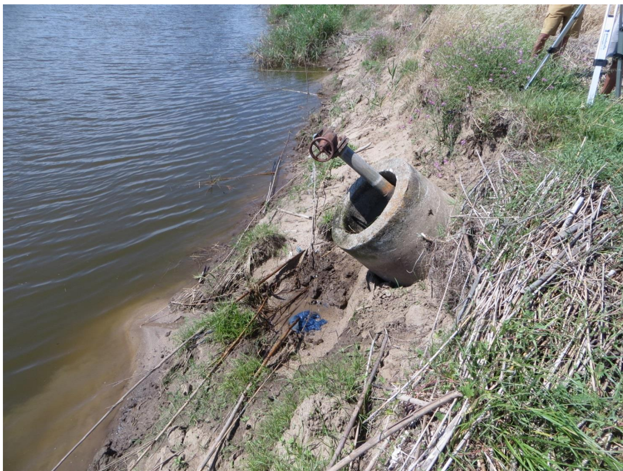
Fig. n. 7 – Bocchetta di presa irrigua, compromessa dall'azione della corrente.
