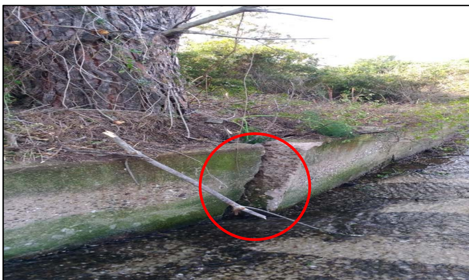
Figura 8 - Frattura della sponda sinistra a causa dell'albero
