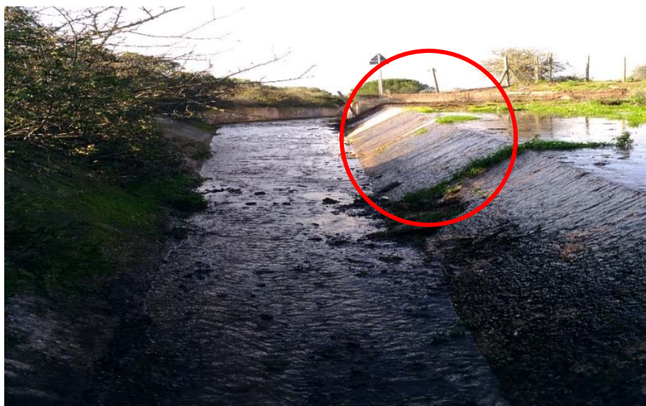
Figura 5 - Sfiatore superficiale e imbocco del canale fugatore
