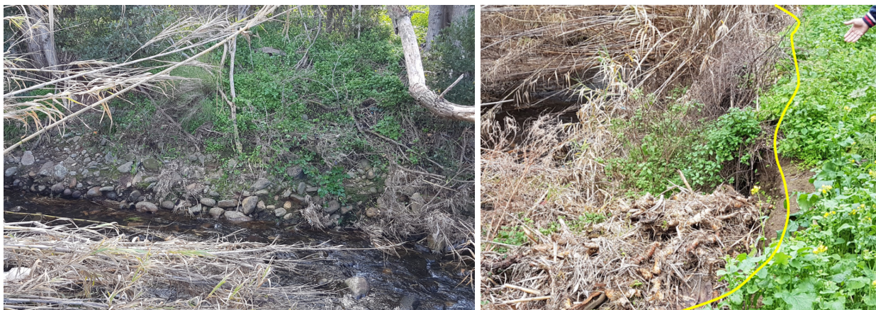
Figure 11: depositi alluvionali ciottolosi nel Riu Mannu e erosioni spondale a seguito cedimento e svuotamento delle gabbionate che costituivano le vecchie opere di protezione (loc. Piscu Piu)
